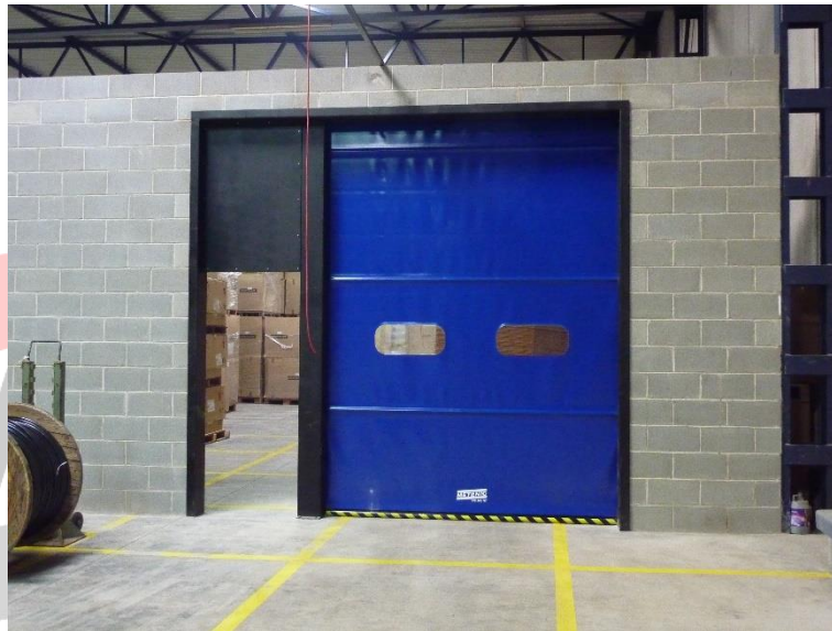
Porta ràpida enrotllable muntada a l'interior.
