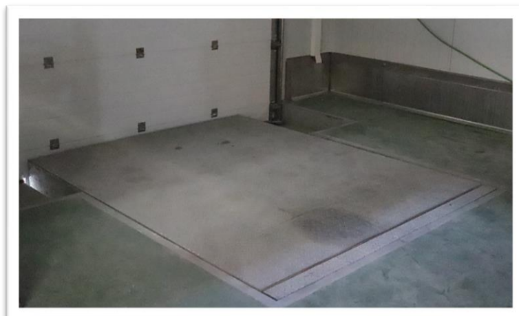
Rampa retràctil amb posició de repòs (sense inclinació)
